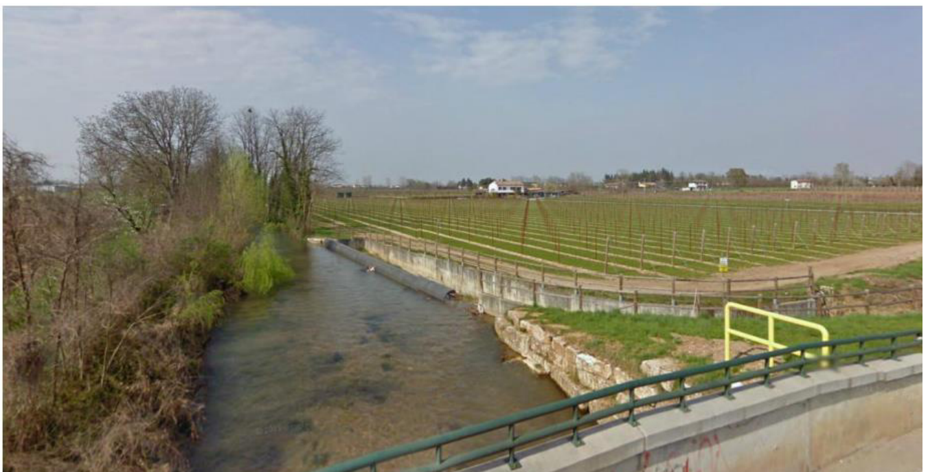
Sfioratore laterale sul Giavera verso cassa di espansione in Comune di Villorba
