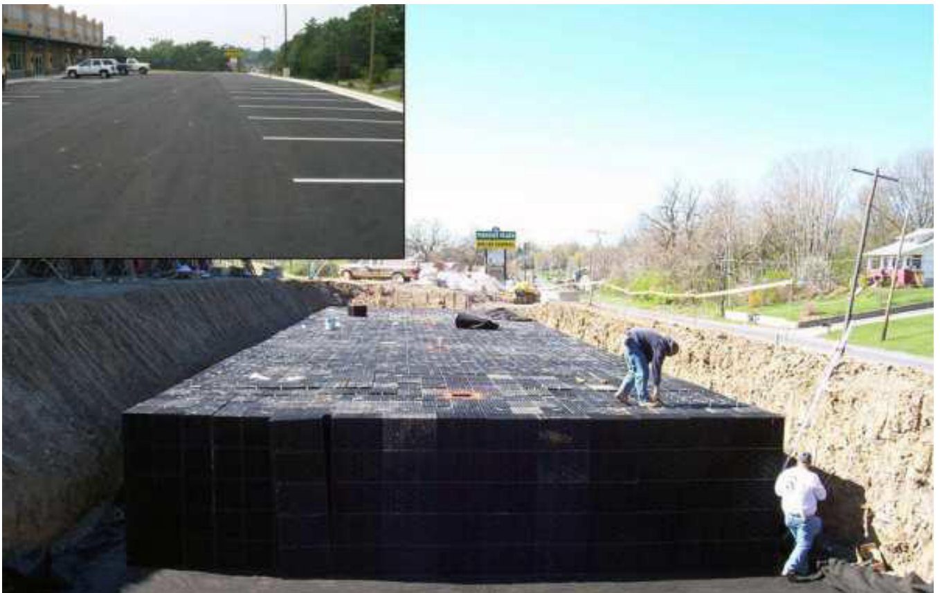
Cella modulare in materiale plastico in fase di montaggio
